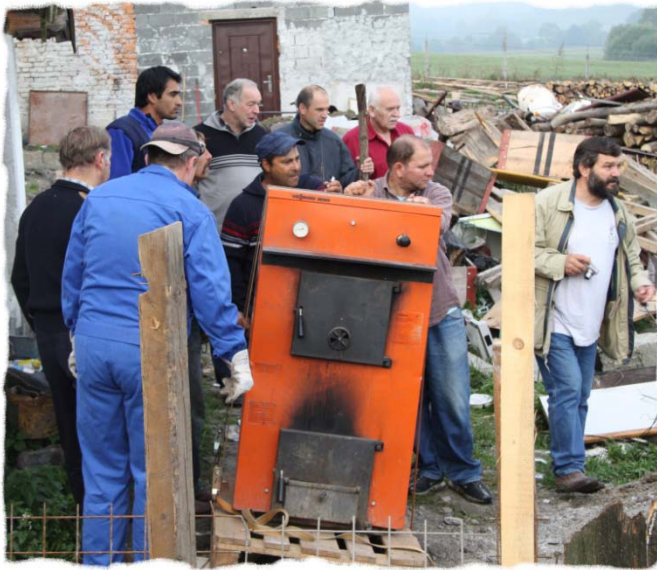
Einbau der Heizungsanlage bei Edi
