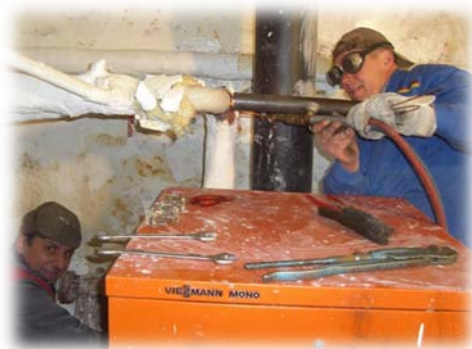
Unsere Heizungsmonteure bei der Arbeit
