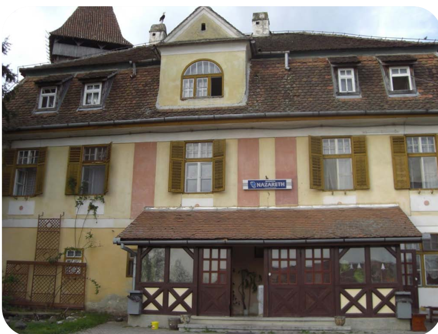
Das Gebäude der Suchtklinik in Sura Mica
