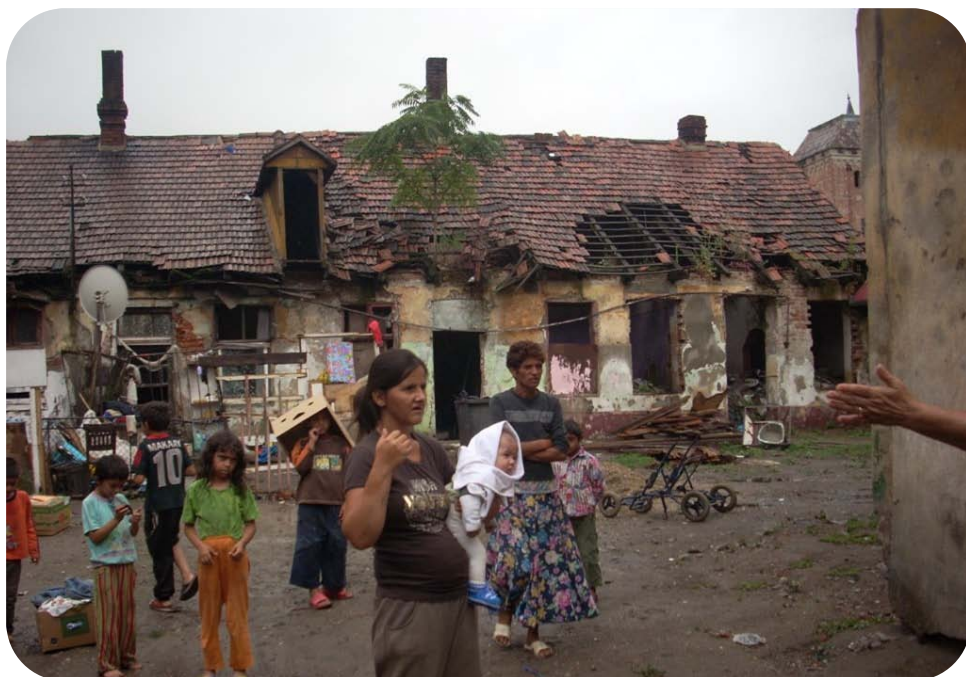
In diesen Gebäuden hausen einige Familien
